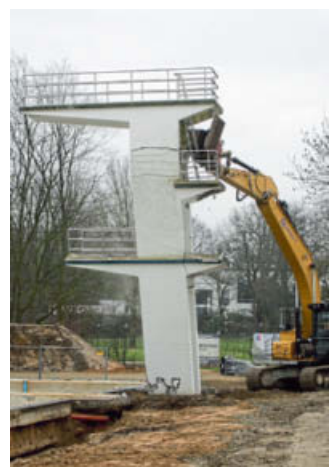
Mit der Schaufel stößt der Bagger den Sprungturm an...
